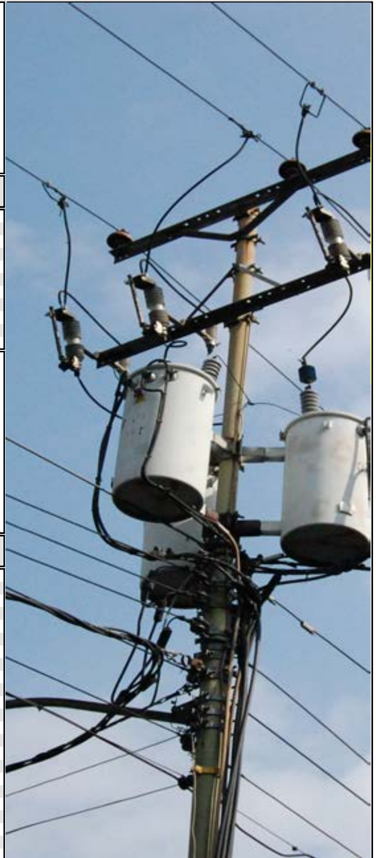
TRANSFORMADORES MONOFÁSICOS DE DISTRIBUCIÓN ENELVEN DISTRIBUTION SINGLE-PHASE TRANSFORMERS ENELVEN
